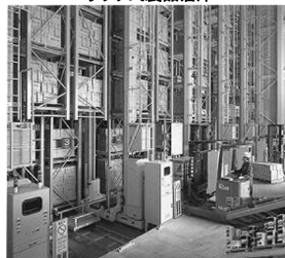
ラック式製品倉庫
